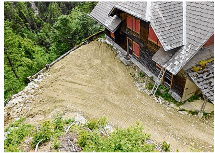
Im Rahmen der Sanierung ist auch der Vorplatz der Forsthütte neu gestaltet worden.
